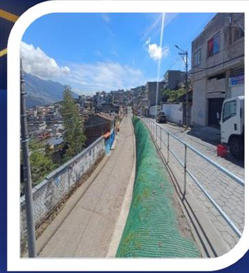
En el barrio 5 de abril, se ejecuto la obra de mitigación a través de la colocación de un geomanto anclado el cual protegerá el talud y evitará posibles deslizamientos, precautelando así la seguridad de las personas.
